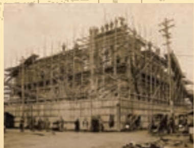
建設中の旧二十三銀行本店(現 大分銀行)
