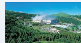
九州電力(株)八丁原発電所(写真提供)
